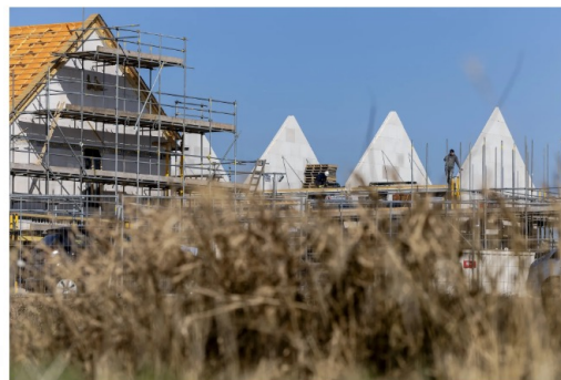
Woningen in aanbouw in het Brabantse Breda. Foto Robin van Lonkhuijsen/ANP
